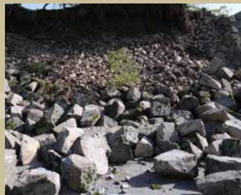
崩壊した熊本城の百間石垣 (画像提供: 熊本県立美術館)
